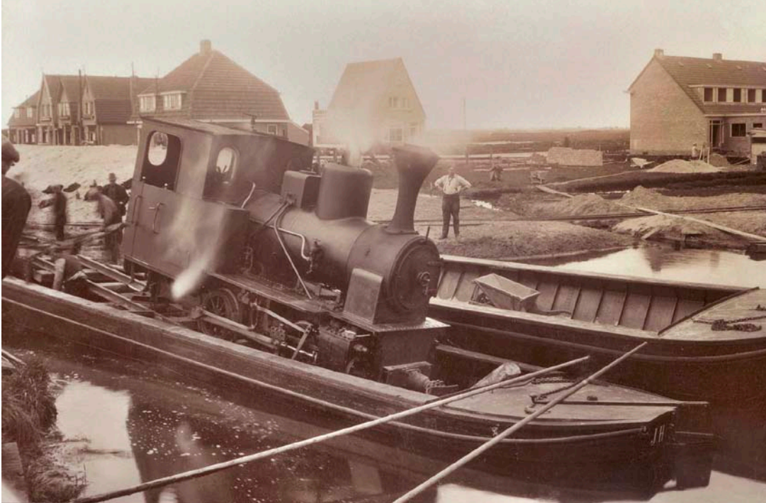
Te zien aan het zandalud op de foto lijkt het werk klaar en wordt de ABM 100 per een zandschuit getransporteerd naar een ander deeltracé.
