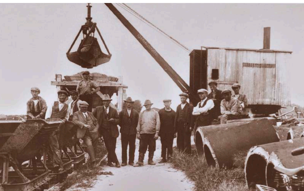
De gehuurde stoomkraan van Welzenbach. De twee mannen met stropdas zijn mogelijk de aannemers. Ze hebben duidelijk geen werkkleding aan. Foto: Collectie Gemeentearchief Zaanstad.
