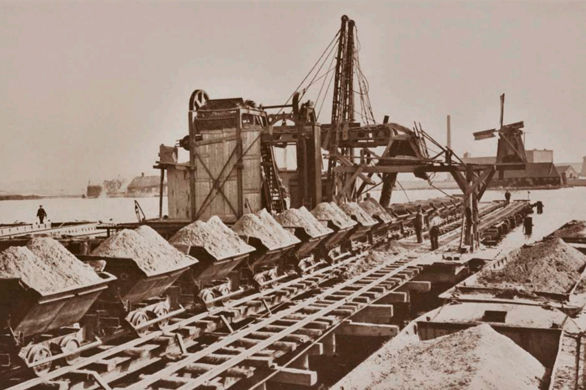
De ABM bouwt in 1930 bij Zaandijk een steiger van 70 meter in de Zaan voor de zandaanvoer voor tracé 15. Foto: Jubileumboek ABM.
