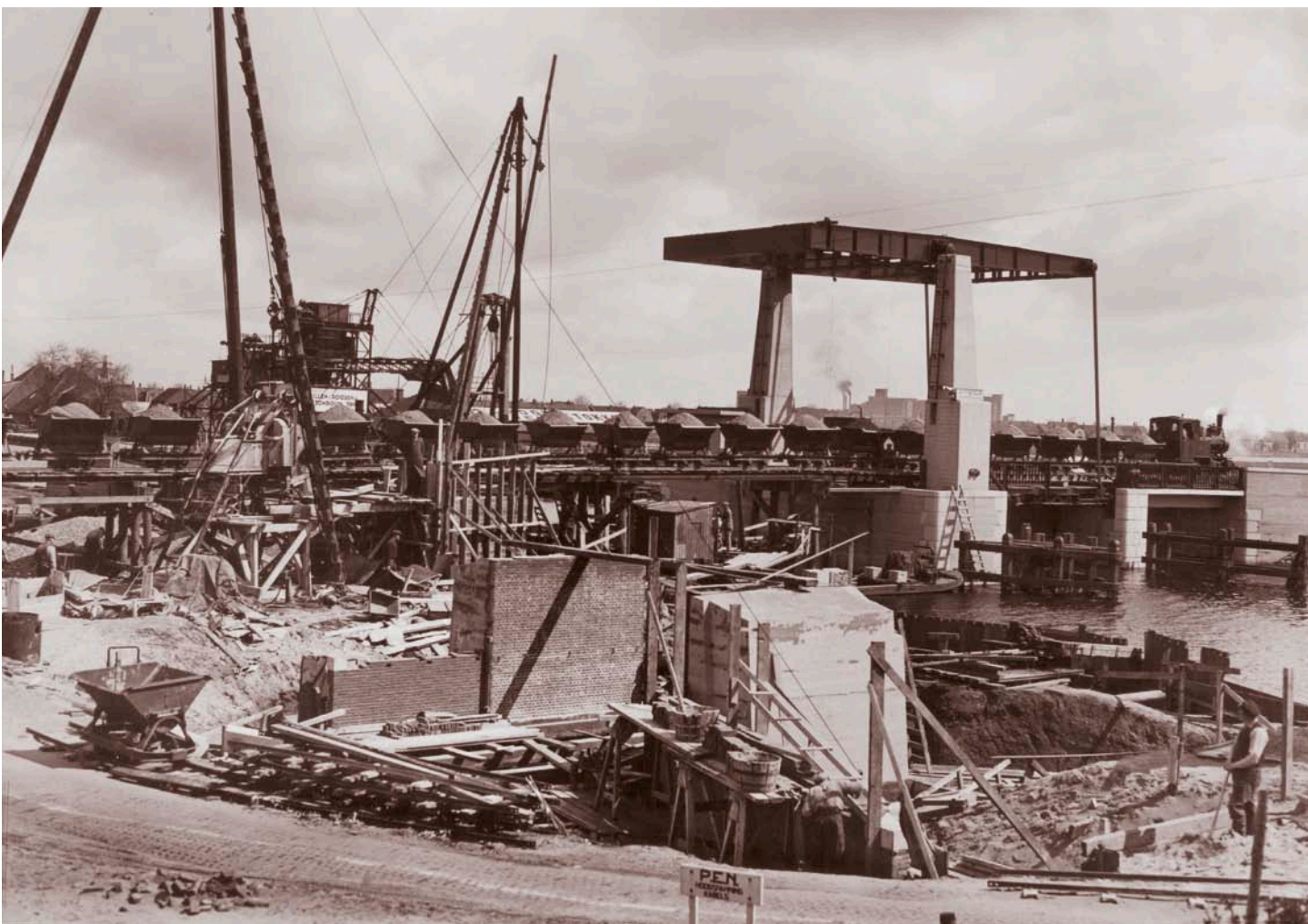
Aannemersbedrijf Hillen & Roosen is verantwoordelijk voor de aanleg van de aardebaan van Wormerveer tot Den Ham. Hier passeert een van de twee Henschel Monta's (60 pk) de al aangelegde brug over de Nauernasche Vaart. Op de achtergrond de elevator waarmee het zand wordt gelost. Foto: Collectie Noord-Hollands Archief.
