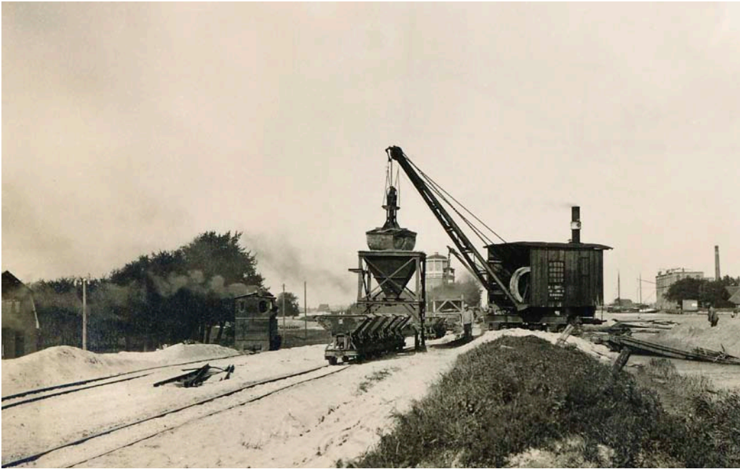
Het overslagpunt aan de westzijde van de Nauernasche Vaart omstreeks 1928 met twee stoomkranen. De voorste is van A. de Groot Czn. Daarachter is nog net de giek zichtbaar van de tweede kraan die werd gehuurd van Welzenbach.
